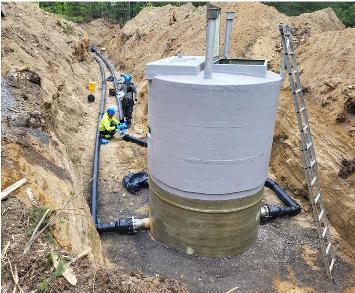
Paineenkorotusaseman asennus käynnissä Kaukalovuori- Salajärvi linjaan. Kuva: Jouni Heikkinen JSP Oy
